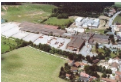
Bild 1: Luftbildaufnahme der Ziegelei Hagelstadt nach Betriebsstilllegung
