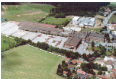
Bild 1: Luftbildaufnahme der Ziegelei Hagelstadt nach Betriebsstilllegung
